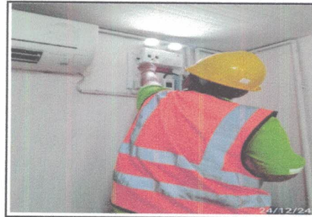
ตรวจไฟฉุกเฉินที่สำนักงานเครื่องชั่ง
