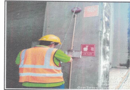
ตรวจอุปกรณ์ส่งเสียงสัญญาณแจ้งเหตุสำนักงานเครื่องชั่ง
