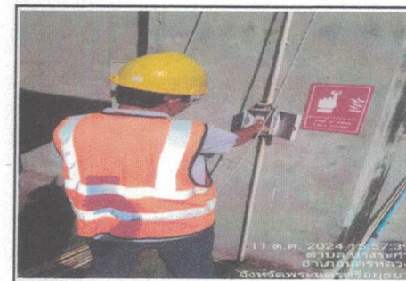
ตรวจอุปกรณ์ส่งเสียงสัญญาณแจ้งเหตุสำนักงานเครื่องจักร
